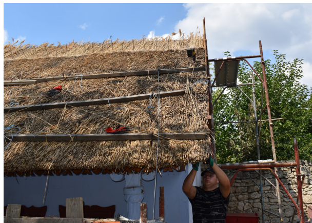
Procesul de realizare a învelitorii din stuf
