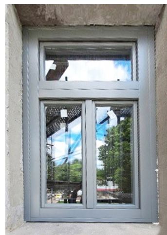
Exemplu de fereastră nouă din lemn stratificat, în două rânduri, cu vitrajul exterior din pachet de geam termopan.
