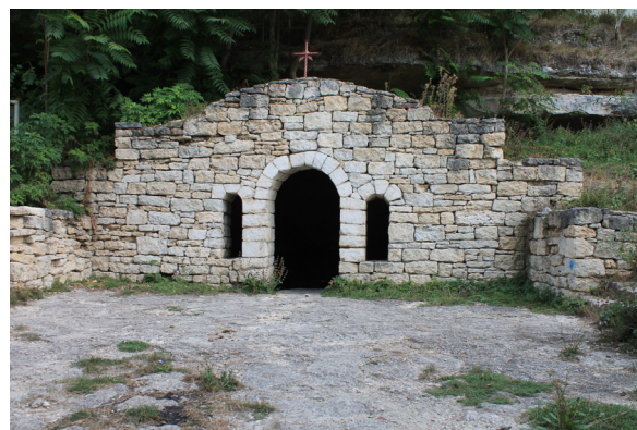
Cișmele tradiționale, caracterizate printr-o structură din piatră ce formează un spațiu interior destinat protejării și izolării sursei de apă.
