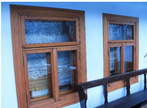
Ferestrele din lemn, montate la fața exterioară a zidului, în două rânduri, reprezintă un element constructiv cu proprietăți termoizolante ridicate.
