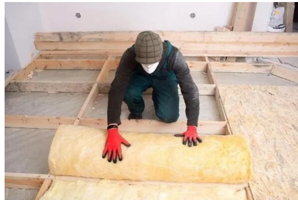
Izolarea termică cu vată minerală, a părții superioare a planșeului existent.
