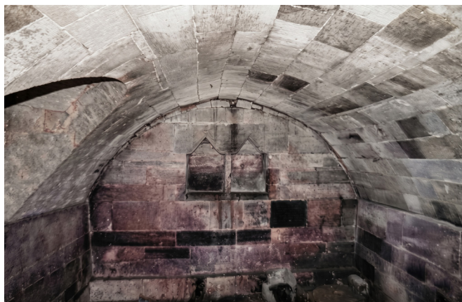
Interior de beci boltit, realizat din piatră prelucrată. Foto E. Bâzgu.
