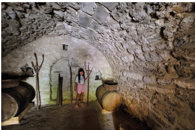
Interior de beci cu acoperire boltit, realizat din piatră. Satul Butuceni, raionul Orhei.
