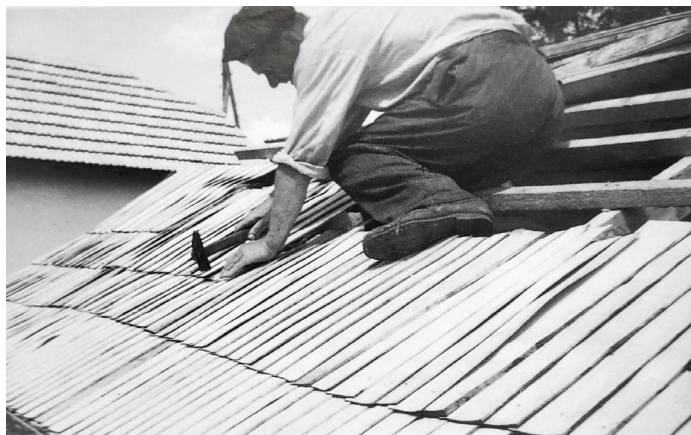
Acoperirea casei cu șindrilă (după V. Buzilă).
